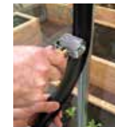
Pose du joint
